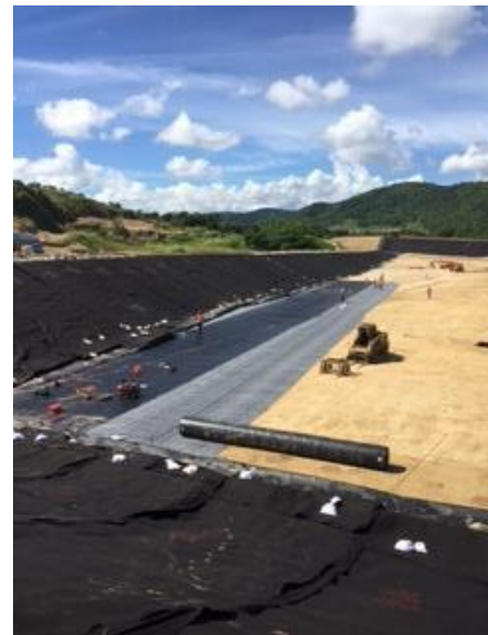
El Coqui Landfill
